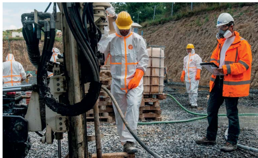
Inovativní technologie vtláčení oxidačních činidel do podzemí na odstranění chlorovaných uhlovodíků
