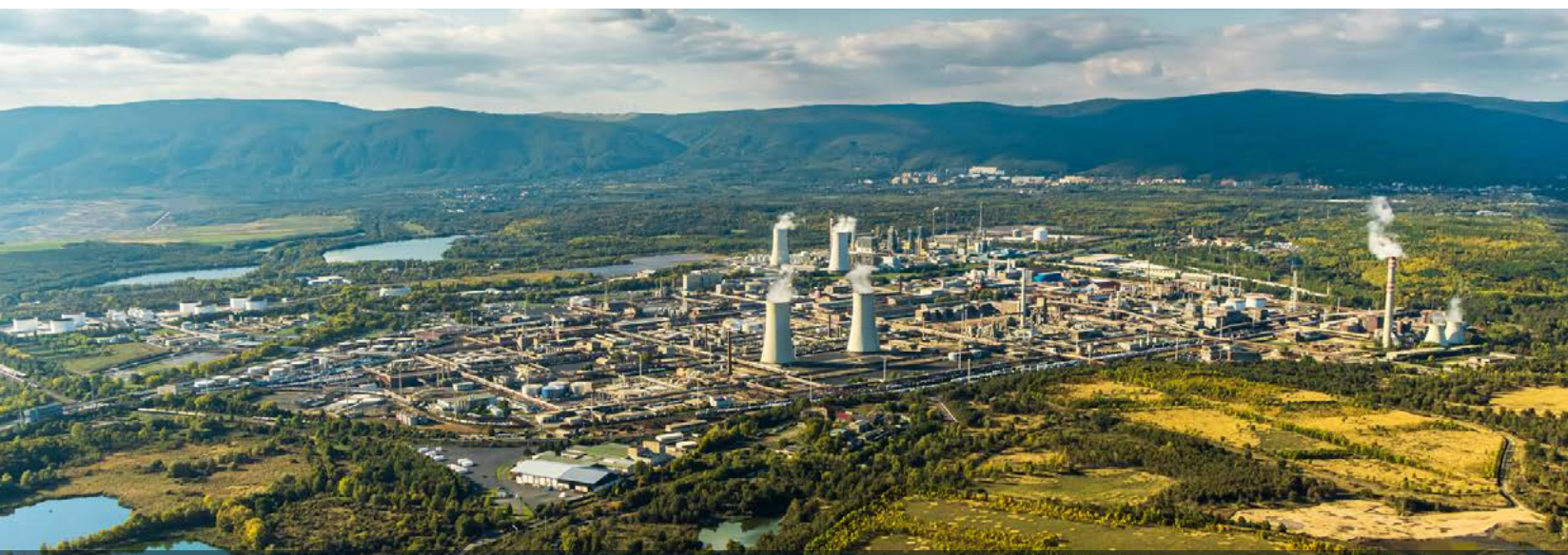
Rafinerie Litvínov, součást skupiny ORLEN Unipetrol, je největší rafinerií v České republice a významným centrem rafinérské a petrochemické výroby v areálu Záluží u Litvínova.
